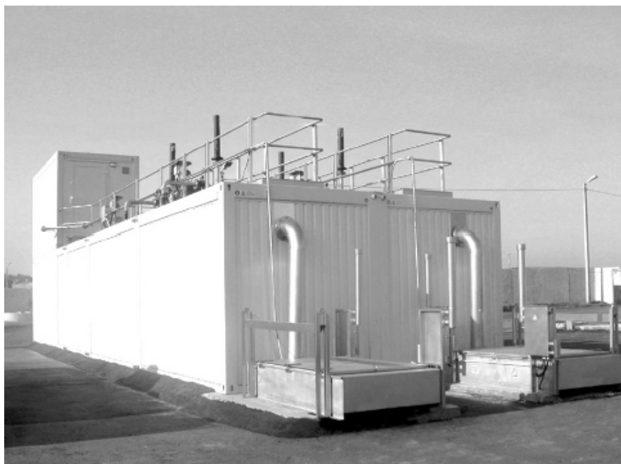
Рисунок 5 – Комплексные локальные сооружения очистки «Адмирал».
